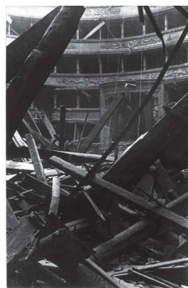
I danni dei bombardamenti alla Scala di Milano
