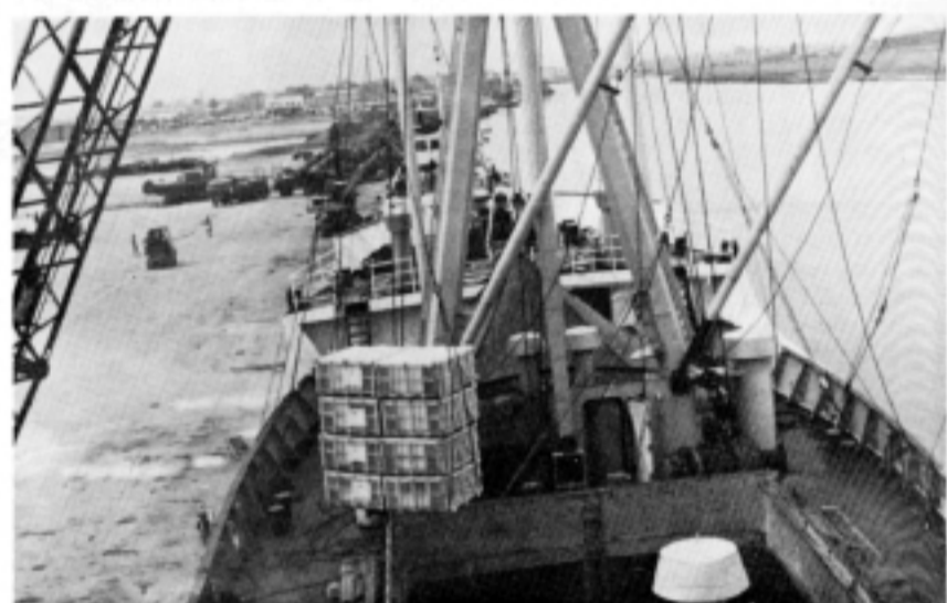
Verso la conclusione i lavori per la nuova banchina a Porto Nogaro.
