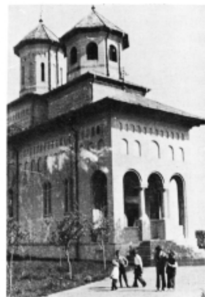
La chiesa di Arsura (Vaslui, Romania) progettata e costruita da operai di Forgaria.
