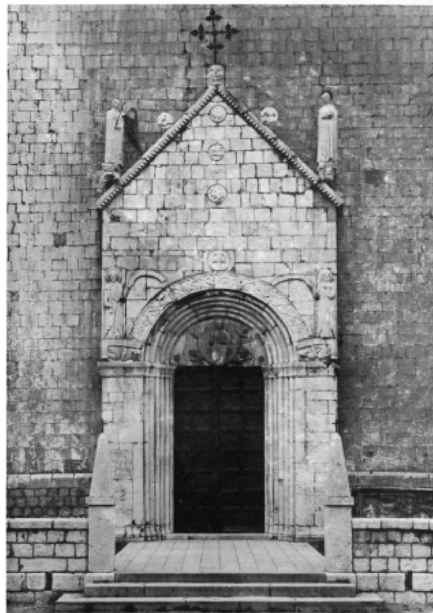
Il portale settentrionale del Duomo di Venzone, prima del terremoto del 1976: una delle testimonianze architettoniche più significative degli inizi del Trecento in Friuli. Oggi è un rudere, numerato nelle pietre che lo componevano.
