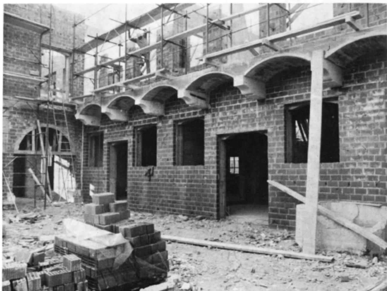
Una casa di Venzone che viene ricostruita dopo attenti studi e con fedeltà alle originali tipologie del centro storico. (Foto Tino)
