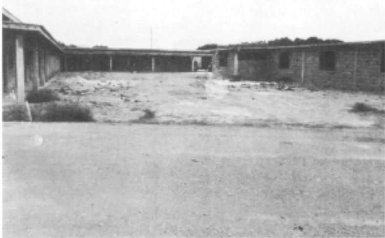
La casa di riposo, in via di costruzione, che gli italiani, coordinati da Elia Leon, un friulano di San Giorgio della Richinvelda, stanno realizzando a Maracaibo, in Venezuela.
