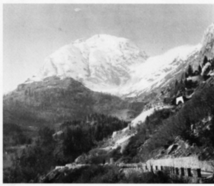
La strada che da Paluzza porta al Passo di Monte Croce Carnico.
