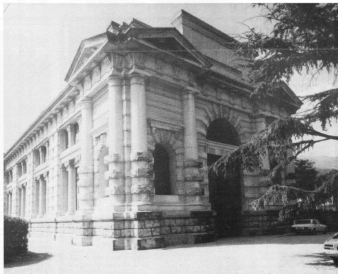
La Centrale idroelettrica di Caneva (Pordenone 1927).
