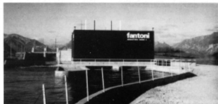
La centralina idroelettrica.
