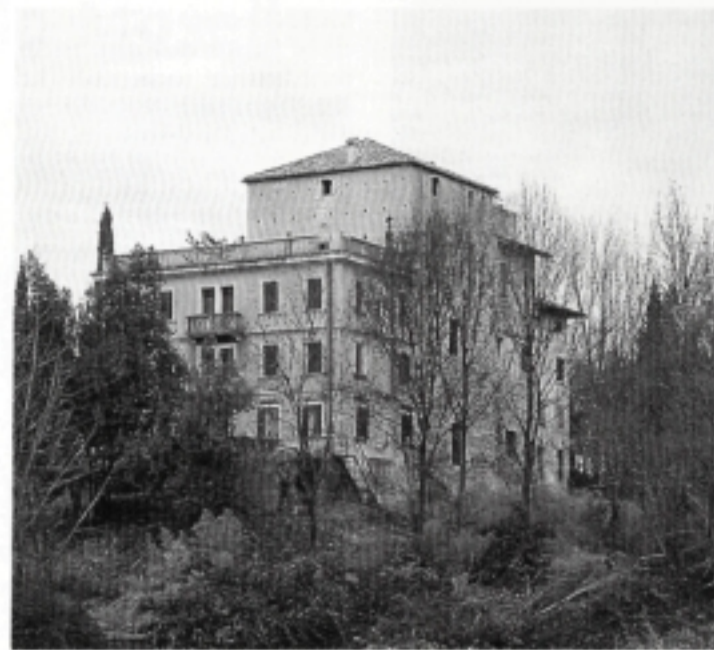
Pordenone, Torre: il castello.
