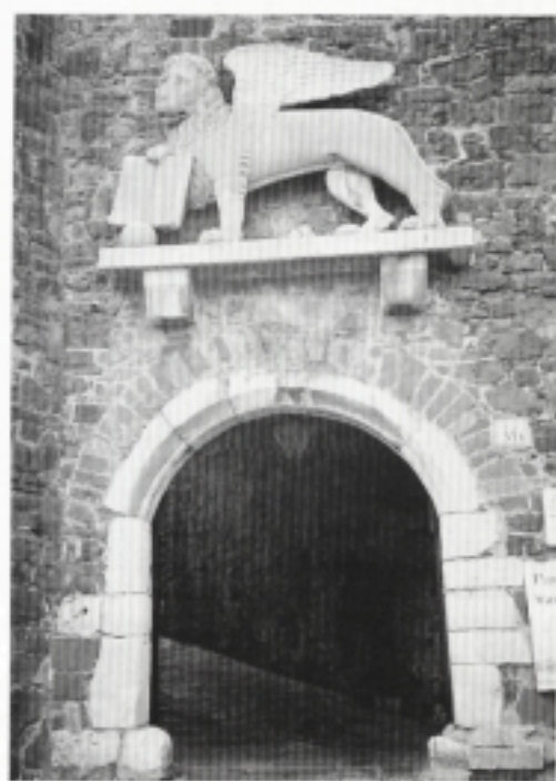
Gorizia: portale d'ingresso al Castello.
