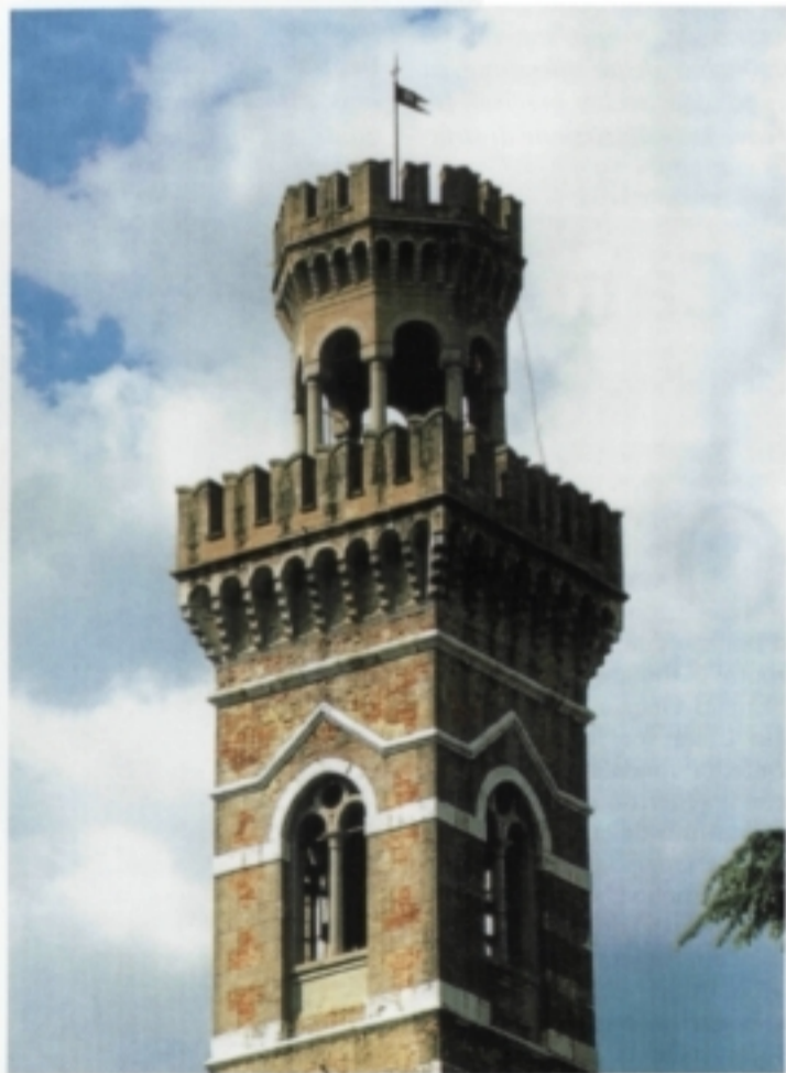
La caratteristica torre campanaria di Caneva opera dell'architetto cavenese Domenico Rupolo.
